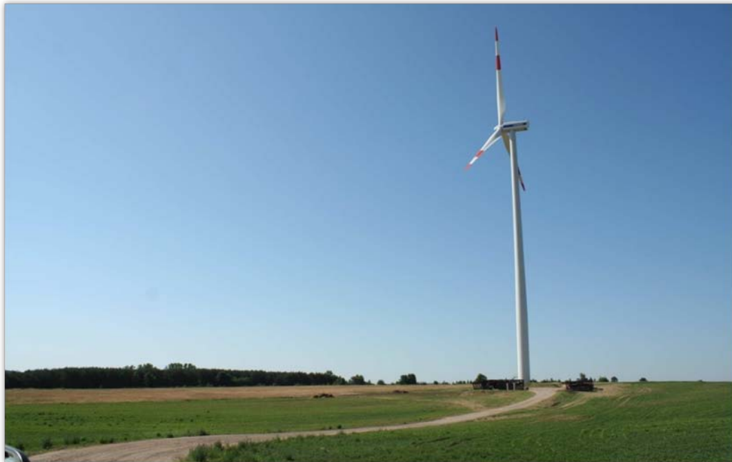
Wittstock-Pampenbruch, Vestas V90, 2MW
