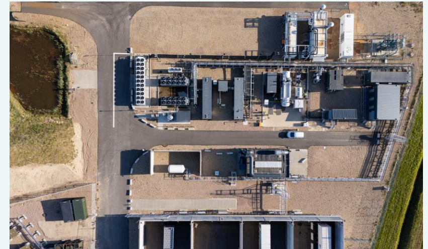
Måde I-II PtX – hydrogen plant in Esbjerg, Denmark
